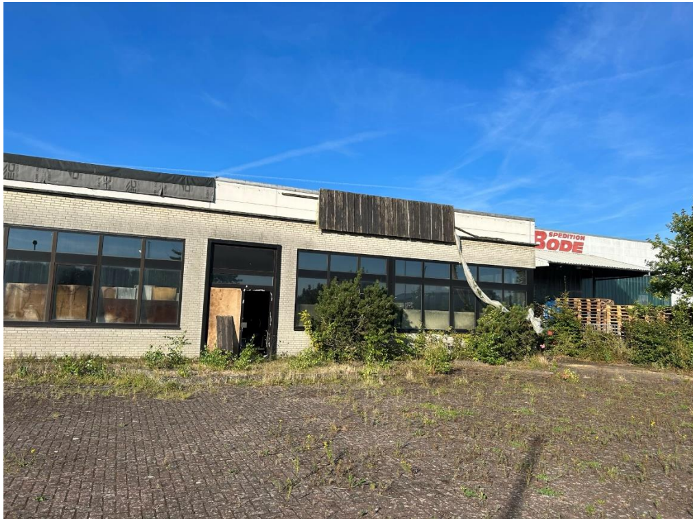
Foto 5: Feldstraße 3, nördliche Halle mit Parkplatz
