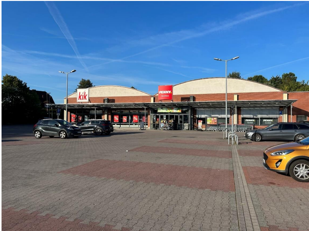
Foto 1: Feldstraße 1, Gebäude mit Parkplätzen, Blick nach Westen
