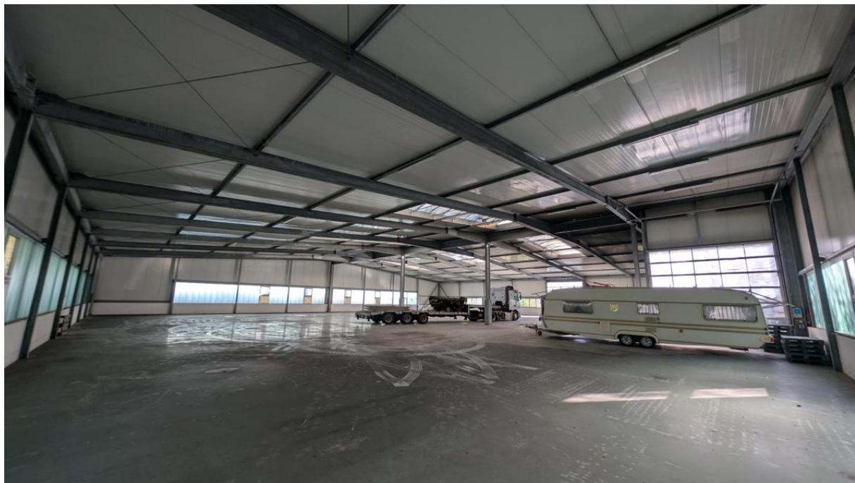
Abb. 2: Innenansicht des westlich gelegenen Stahlbaugesbäudes. Aufgrund der geschlossenen Konstruktion und fehlender Einflugmöglichkeiten bestehen hier keine relevanten Quartier- oder Brutplatzstrukturen.
