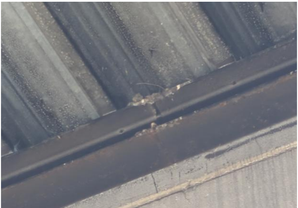
Abb. 6: Neststandort der Rauchschwalbe ( Hirundo rustica ) im Bereich der Dachkonstruktion des östlichen Gebäudes. Die Lage des Nestes in einer geschützten Spaltenstruktur verdeutlicht die Bedeutung des Gebäudes als Fortpflanzungsstätte für gebäudebrütende Vogelarten im Sinne des § 44 BNatSchG.
